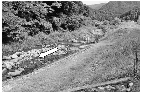
写真6 二ヶ堂橋上流.
