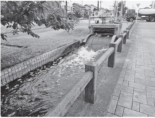
図2 ①放水口 神通川左岸浄化センターの処理水が利用されている
