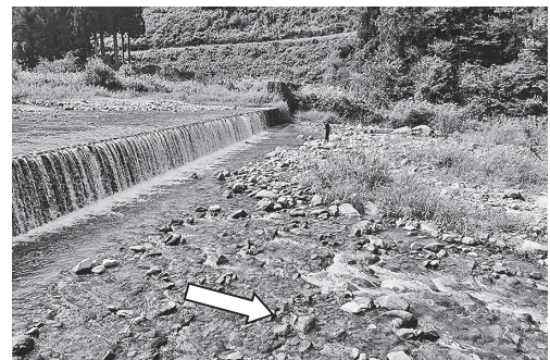
写真6 中河内堰堤下流
