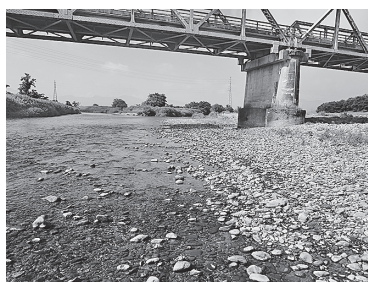
図2 小矢部川 川崎橋
