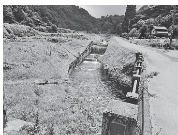
図12 糸谷川 糸谷橋
