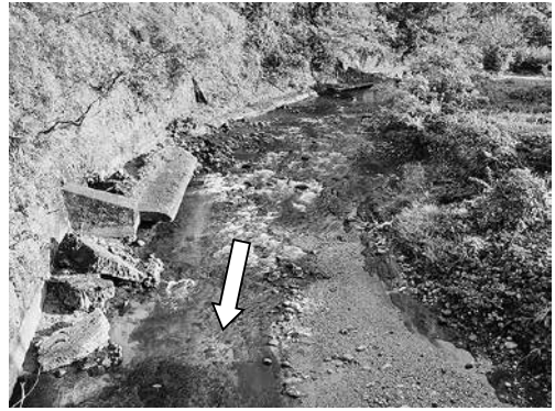
写真1 高熊落合橋上流
