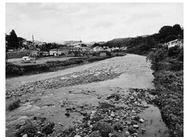
図12 八尾大橋（井田川）
