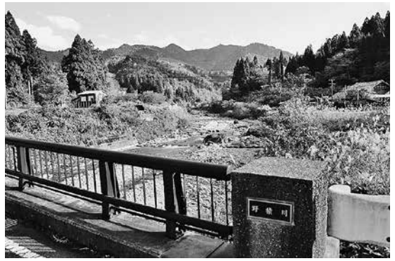
写真2 松瀬橋（八尾町西松瀬）
