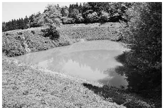
写真6 桜窪ため池（八尾町宮ノ下）
