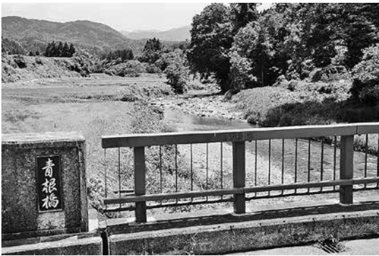
写真3 青根橋（八尾町水口）
