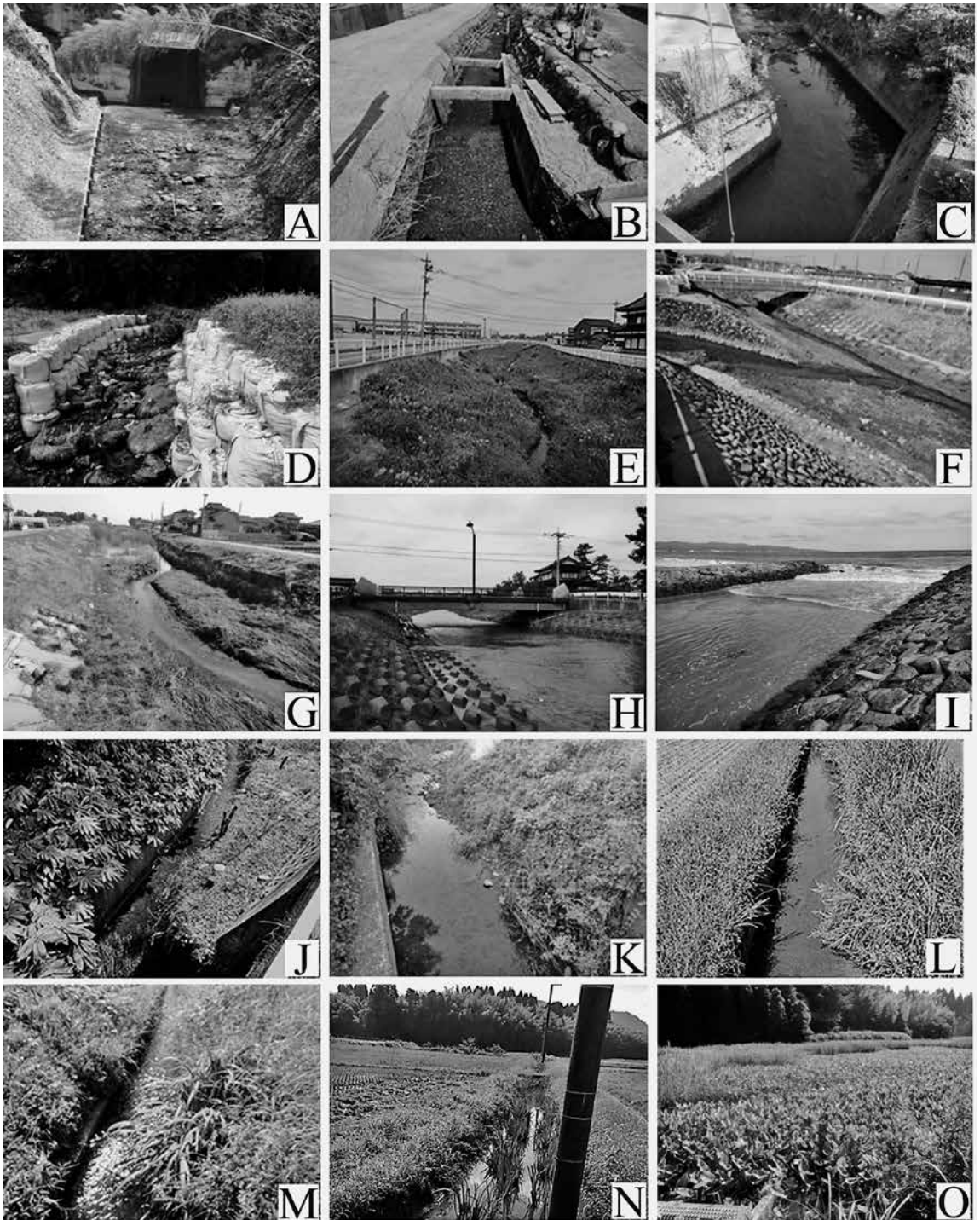
図3 泉川水系における主要調査地点の外観 A, 小竹 道の湾曲部 (5.5km); B, 小竹 毘沙門堂道口 (4.5km); C, 下田子 バス停付近 (2.8km); D, 上泉 泉の杜北 (1.6km); E, 島尾 島尾橋 (0.9km); F, 島尾 泉川-新川合流点 (0.8km); G, 島尾 島尾新橋 (0.5km); H, 島尾 松田江橋 (0.1km); I, 島尾 泉川河口; J, 小竹 東海老坂前 (5.2km); K, 小竹 公民館前 (4.9km); L, 島尾 (1.7km); M, 宮田 新川支流 (2.0km); N, 宮田 トンボハウス西水路; O, 宮田 乱橋池 (カッコ内は河口からのおおよその距離)
