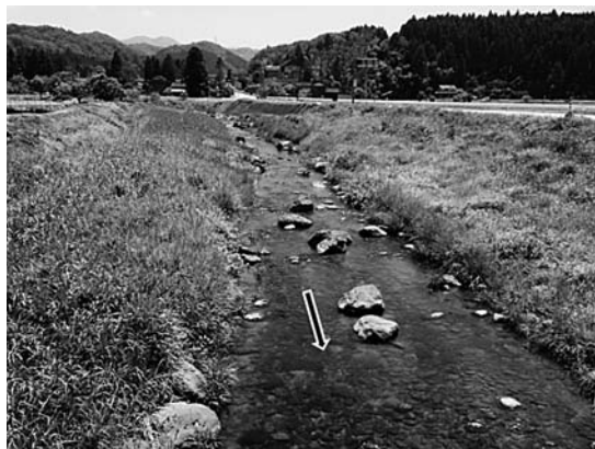
写真2 黒川橋上流（地点①）
