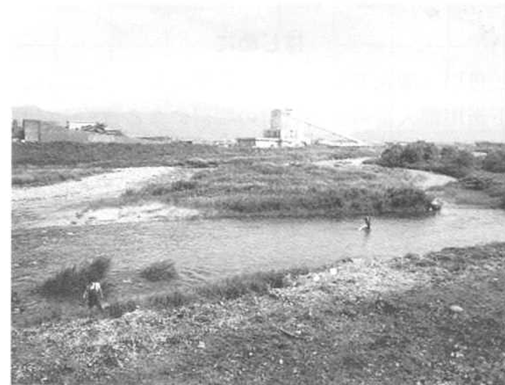
図5 新小川橋 小川との合流点
