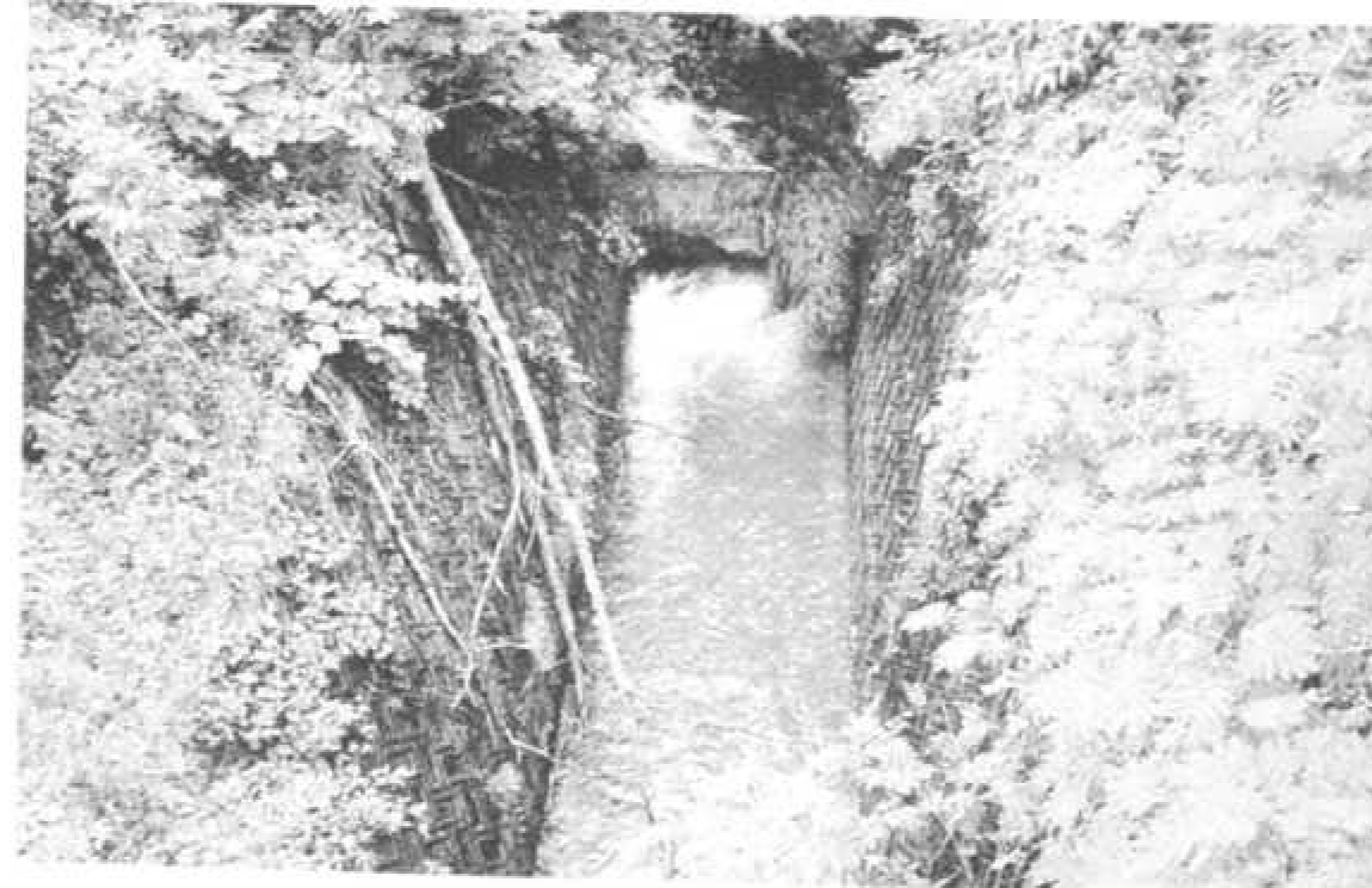
〔定点5：西平橋周辺〕
