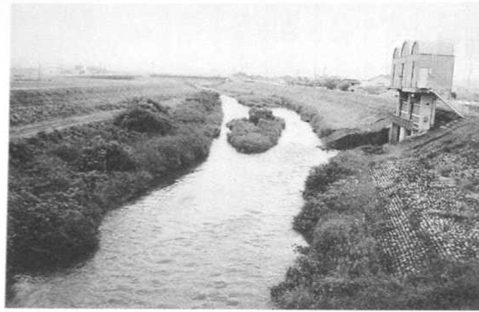
〔定点1：綾子大橋周辺〕
