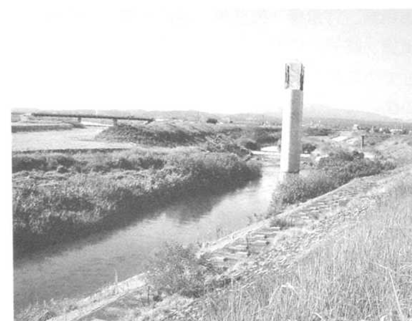
島分橋<小矢部川との合流点付近>
