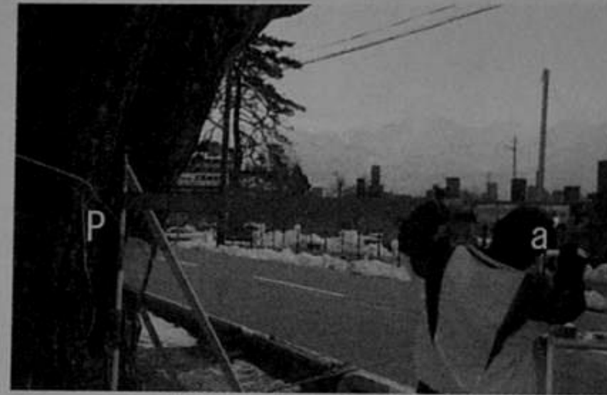
図6 a' - P間距離の測定状況
