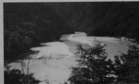
写真2 砂で埋まった出し平ダム
