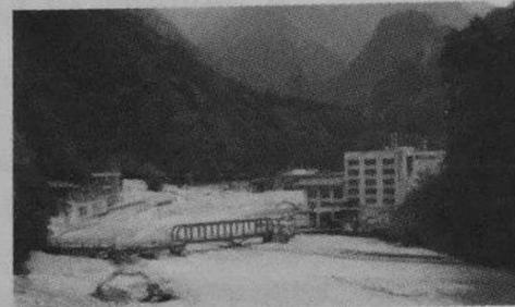
写真4 猫又谷からの土砂が発電所に到達
