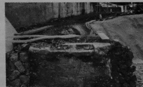
写真3 土砂崩れで切断された軌道
