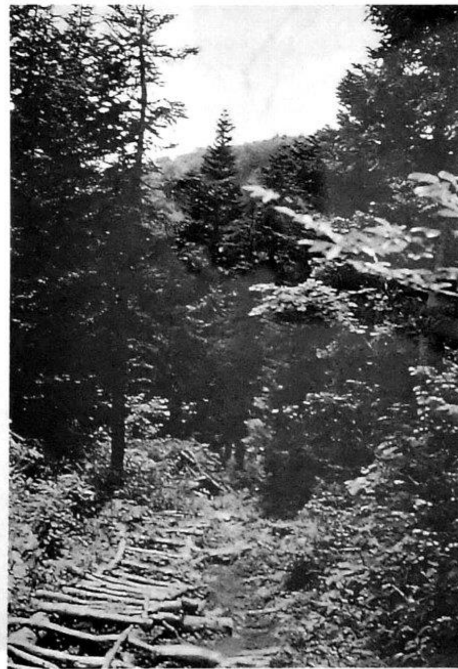
黒四ダム建設時に、立山の一の越から敷設された樹木利用の運搬路。
