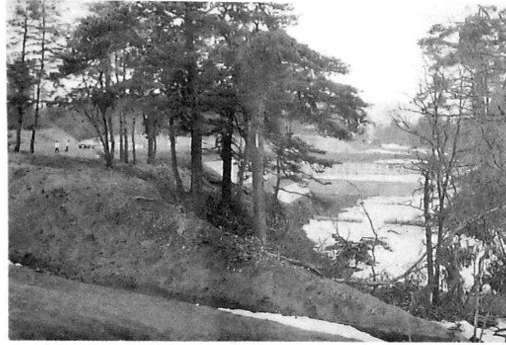
水害防止や堤防崩壊に利用したクロマツ林
