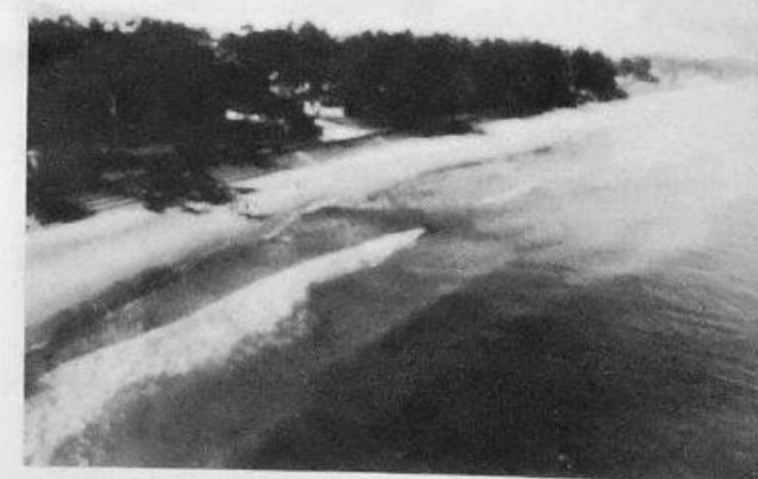
護岸堤で守られた朝日・宮崎海岸林
