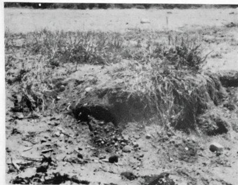
富山・岩瀬浜の浸食による土砂露出
