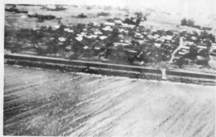
入善・春日集落を守る護岸堤
